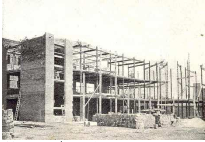
Aixecant les primeres parets.
